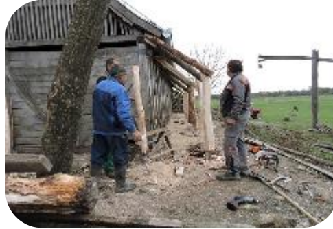
Radovi na infrastrukturi
